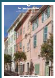
01 les façades enduites
